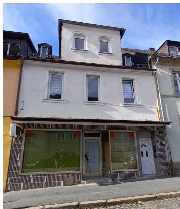
Schaufenster, Vordach, Fassadenverkleidung EG
