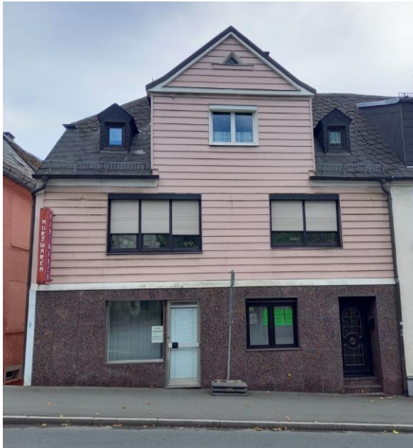
Fassadenverkleidung, Fenster- und Türelemente
