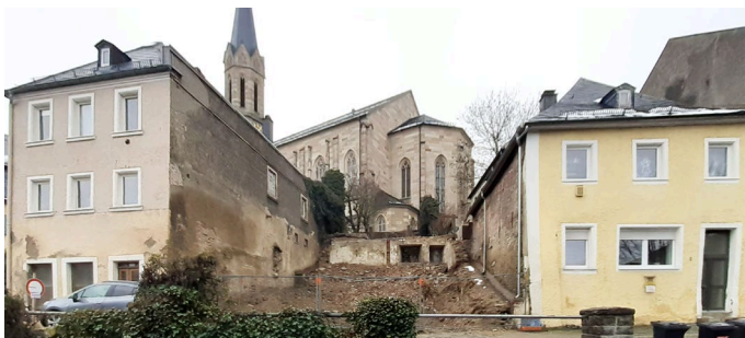
Situation nach erfolgtem Abbruch des Anwesens Torgasse 4
