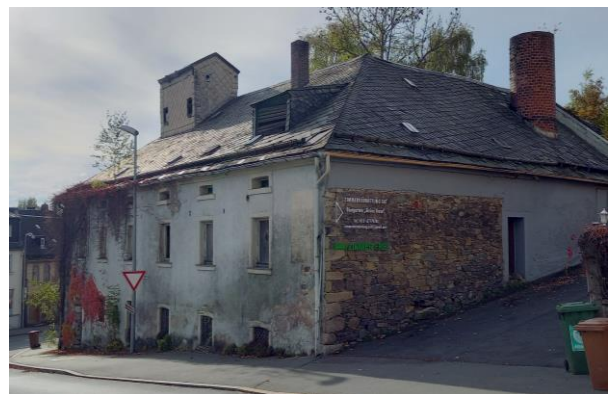
Bismarckstraße 7 „ehem. Mälzerei“
