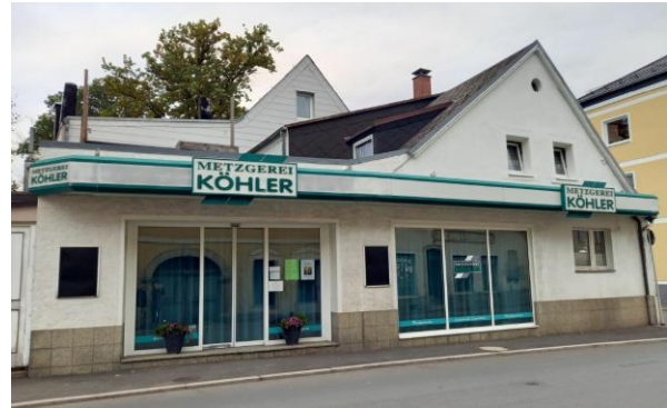
Störender nachträglicher Anbau, Schaufenster
